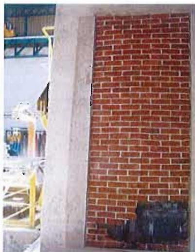
Photo 2 : vue échantillon plaquettes de 20 mm
